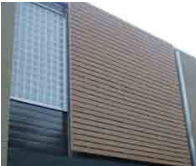
Rivestimento esterno edificio con estrusi a base legno (Foto per concessione MaTech).
